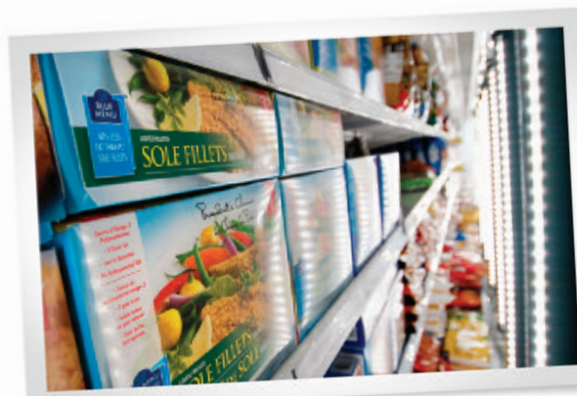
Des lumières DEL écoénergétiques activées par le mouvement, dans les congélateurs du magasin Loblaw Superstore de Scarborough.
